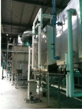
**一般固定床的吸附系統**，在遇有高反應性的VOCs處理時(如含酮類VOCs)，常被碳床腐蝕或碳床著火等問題困擾，為了改善固定床吸附系統的缺點，日本公司因此而發展出一種流體化床的吸附系統。此系統的特徵是改良活性碳的吸附及飽和碳的脫附再生為一連續操作，系統各主要可分為三部份，即吸附塔、脫附塔及冷凝塔或燃燒機；依使用的目的不同可為**VOCs廢氣處理**或廢氣濃縮除臭之用，目前在日本已廣泛的用於各種行業，例如工業之**廢氣處理**，國內也應用在光電業等之VOCs廢氣排放前濃縮淨化處理之用。然而，卻因部份技術瓶頸而受限於產業應用。
